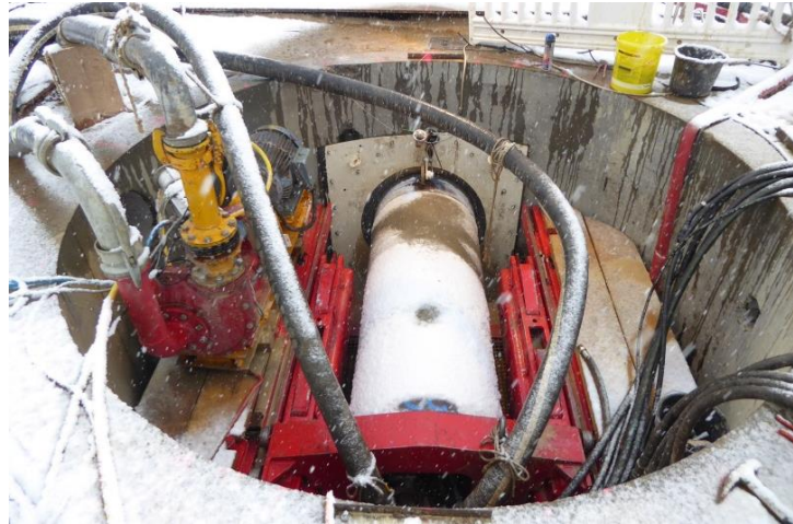
Microtunneling (-Verfahren) DN 600
